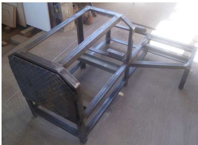
Figura 3.6 Estructura previamente diseñada en proceso de construcción
