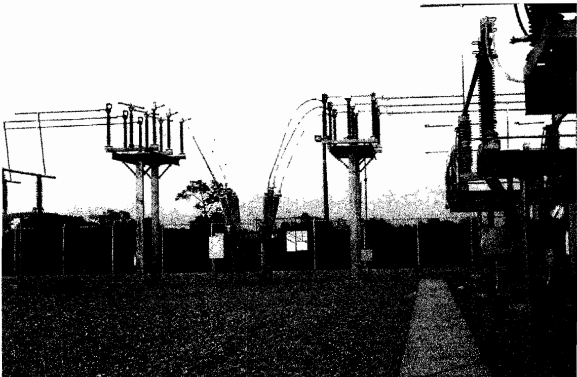
FIG. 5.9 Seccionadores y disyuntor de posición MAC1 S/E San Idelfonso
