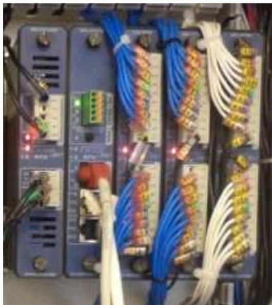
Figura 2.22 RTU, equipo principal del tablero de control
