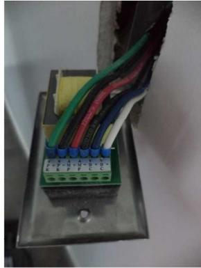
Figura 2.39 Instalación de control de volumen.
