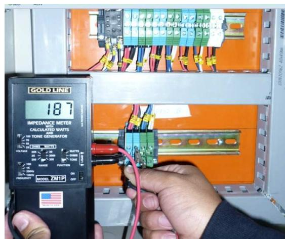
Figura 4.5 Medición de impedancia en tablero de primer piso.
