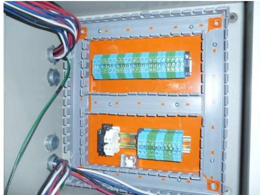
Figura 2.30 Instalación de los tableros de borneras de paso
