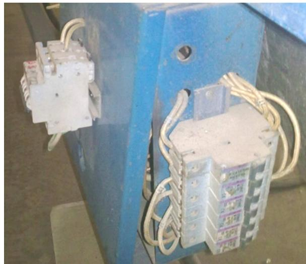
Fig.1.16 Tablero de protección de las resistencias.
