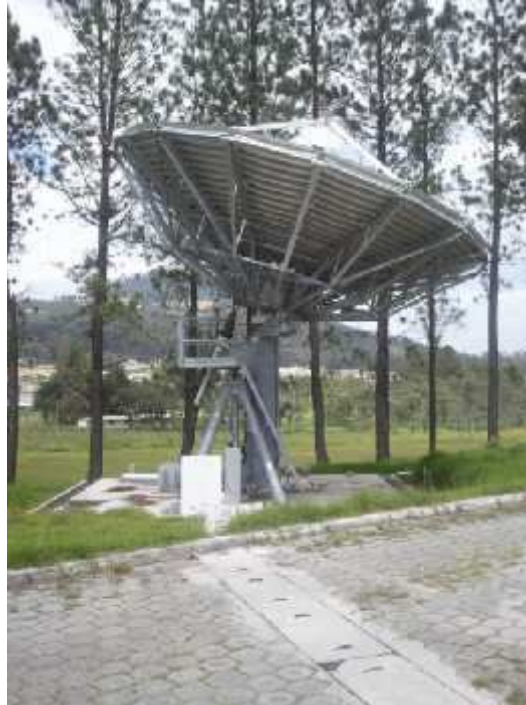
Figura 3. 21 Antena de 9 metros de diámetro con su pedestal
