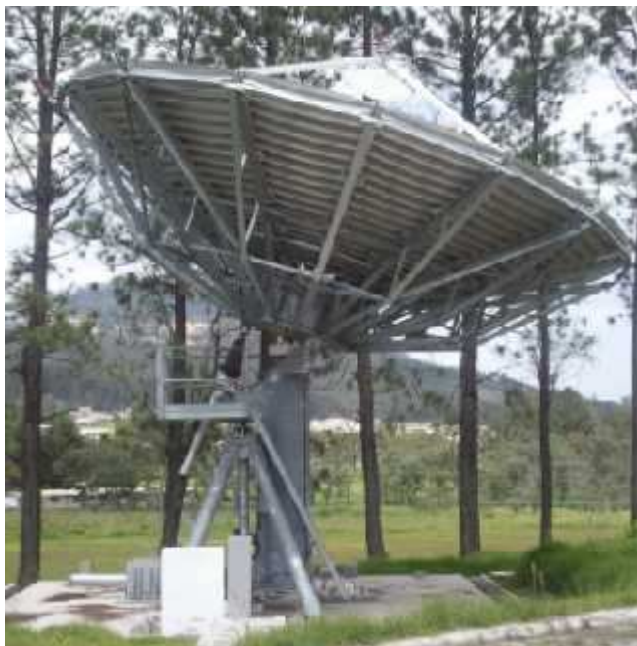
Figura 3. 3 Antena de 9 metros de diámetro en el HUB
