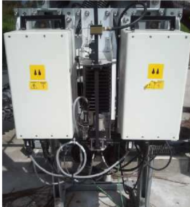
Figura 3. 22 HPA de 200 watts de potencia
