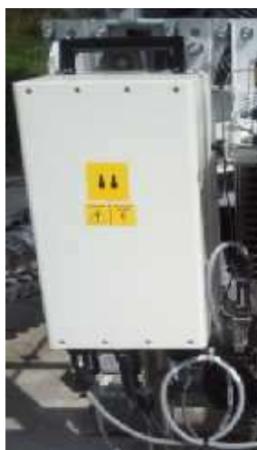
Figura 3. 4 HPA DE 200 watts de Potencia
