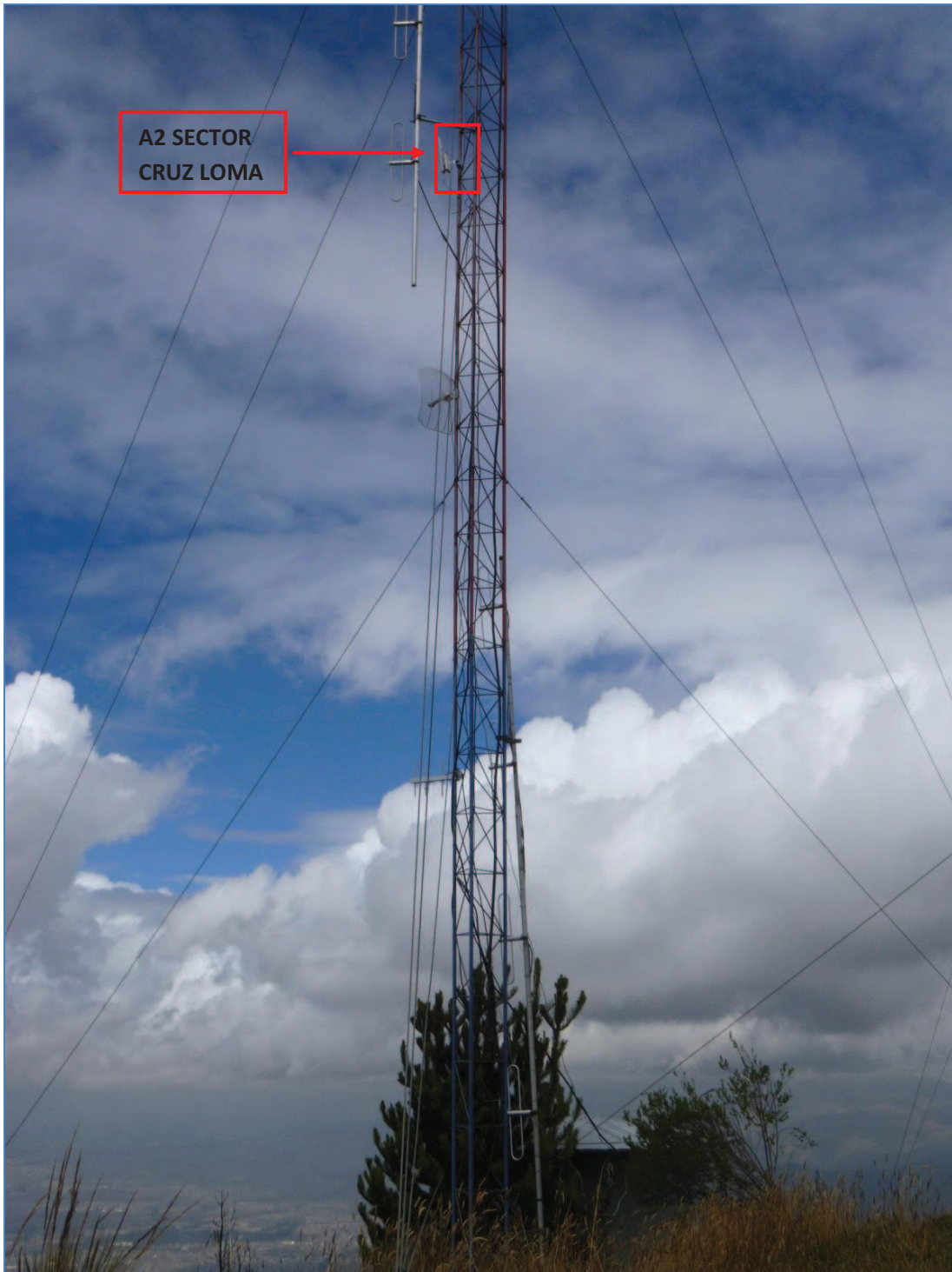
Figura 3. 2 Estructura Cruz Loma
