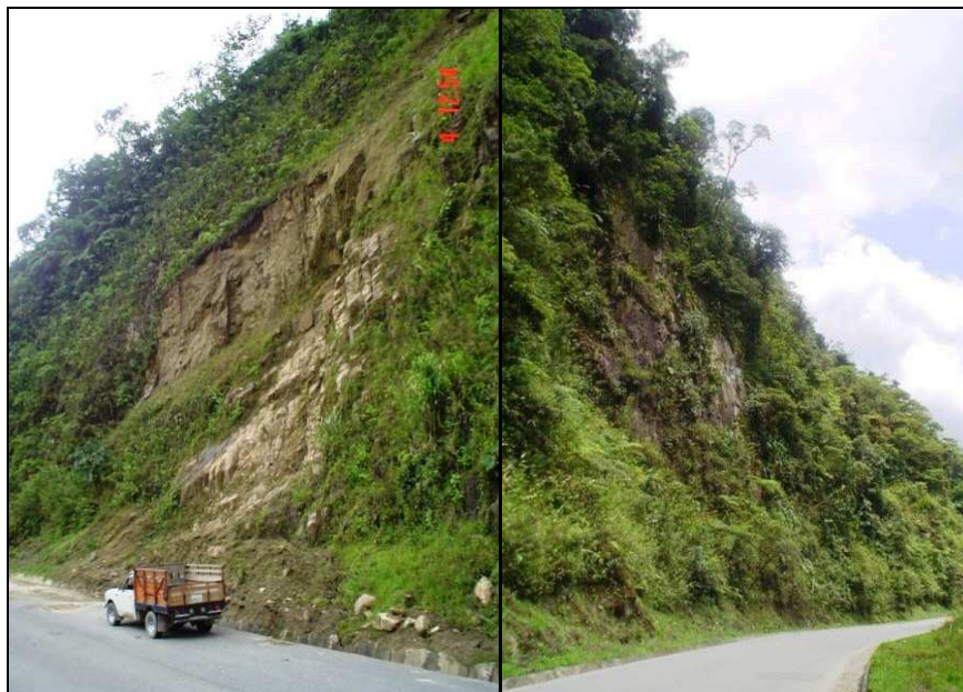
FOTOGRAFÍAS 2.14 y 2.15. Paredes verticales de gneises: (Foto 2.14) Afectado por caída de rocas. Vista hacia el SE. Sector Río Sabanilla (Foto 2.15) Talud relativamente estable. UTM: 720219-9559070.
