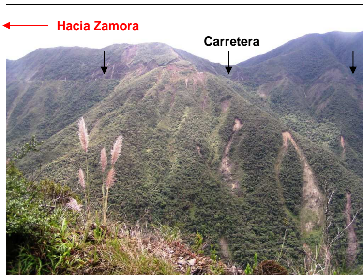
FOTOGRAFIA 2.12. Flujos y avalanchas de detritos en rocas metamórficas (U. Chiguinda). Vista aproximada hacia el SE. UTM: 709191-9559279
