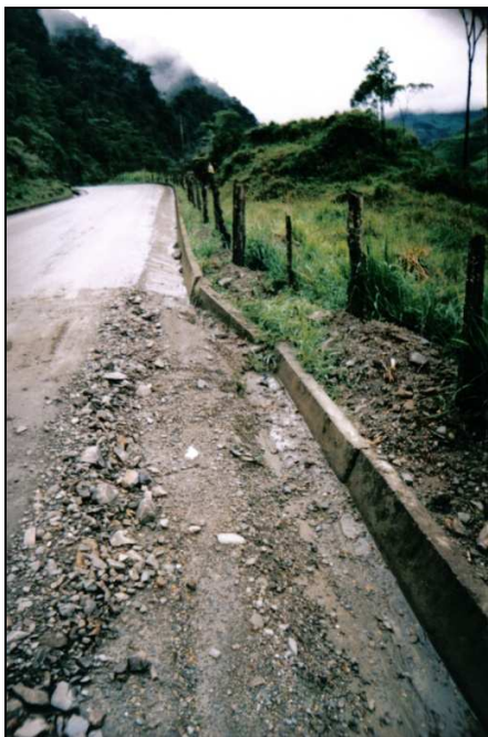
FOTOGRAFÍAS 3.4 y 3.5. Daños en la carretera: ( Izquierda ) Asentamiento y pérdida de alineación de la cuneta de la vía UTM: 720219-9559070 ( Derecha ) obstrucción parcial de la carretera por avalancha de escombros. Sector El Retorno UTM: 719111-9562808
