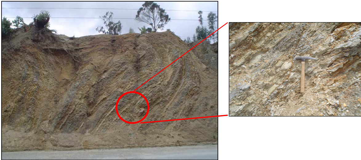
FOTOGRAFÍA 2.7. Pliegue afectado por fallas en el Miembro Limolita (Fm. San Cayetano). Vista aproximada NE. UTM: 700586-9559549
