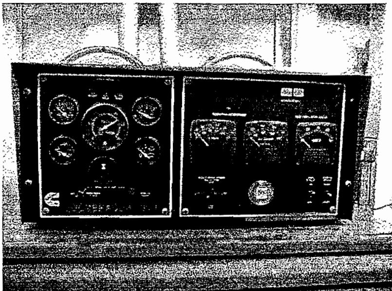
Graf. 6 Panel de control marca CUMMINS antes de insertar módulo automático.
