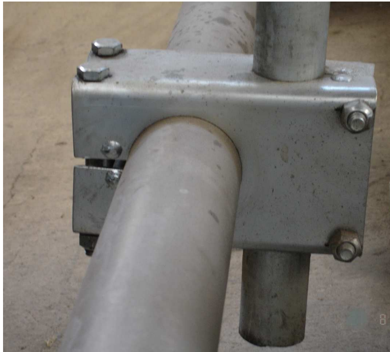
1.9.4.8.1.1.7 Fig. 3.20: Articulación de Soportes
