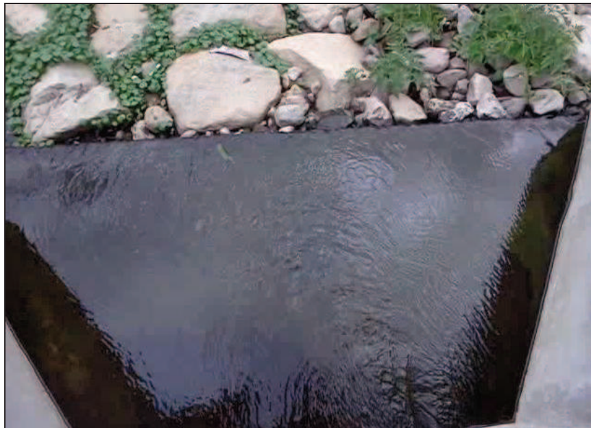
Gráfico 26. Punto de descarga de aguas tratadas - Planta de tratamiento San Miguel Bajo - Lago San Pablo
