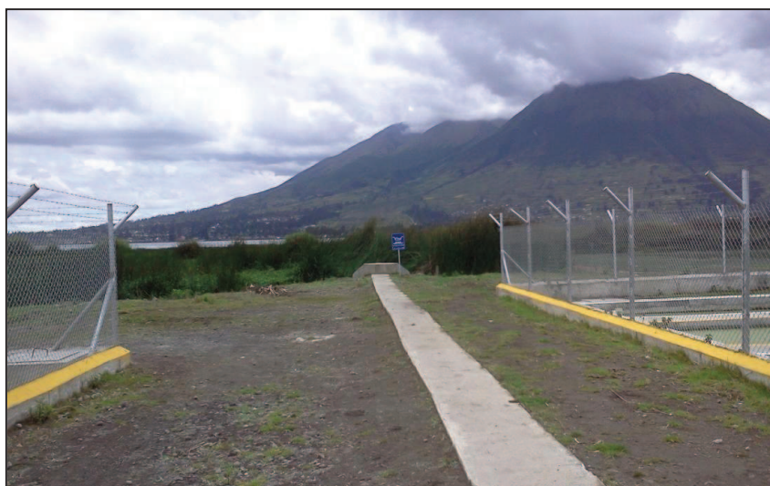
Gráfico 25. Tubería de descarga de aguas tratadas - Planta de tratamiento San Miguel Bajo - Lago San Pablo
