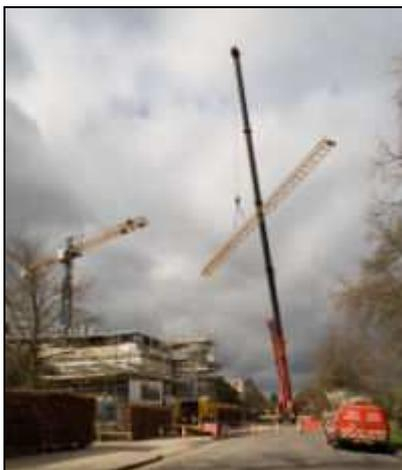
Figura 1.3.- Una grúa telescópica que desmonta una grúa de torre de 40 m en Cambridge, Reino Unido.<sup>5</sup>
