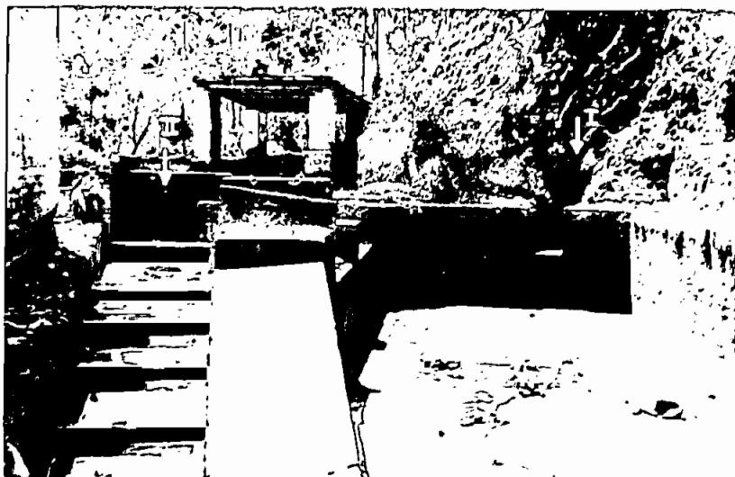
Fotografía N°. 8.- Vista Parcial de los tanques de sedimentación y presión, indicando la llegada de los dos ramales del canal.
