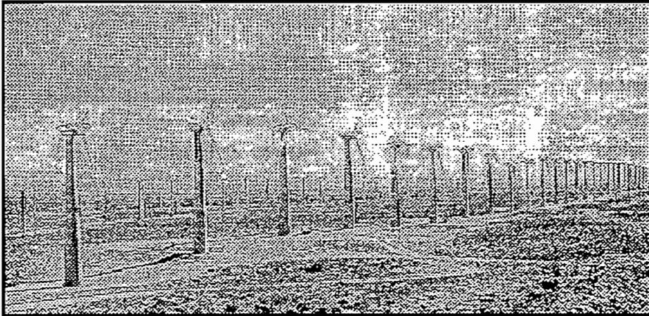
Las turbinas seleccionadas de acuerdo a la disponibilidad y formas del terreno en Páramo Grande se localizarán en arreglos de 3 filas y 30 columnas, para obtener la capacidad de 7,2 MW (8,3 MVA). En Cotopaxi se prevé la instalación de 2 filas y 30 columnas para obtener 4,8 MW (5,5 MVA).
