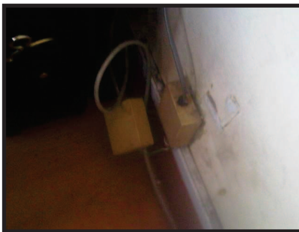
Figura 2.46 Roseta para conexión de fax y teléfono
