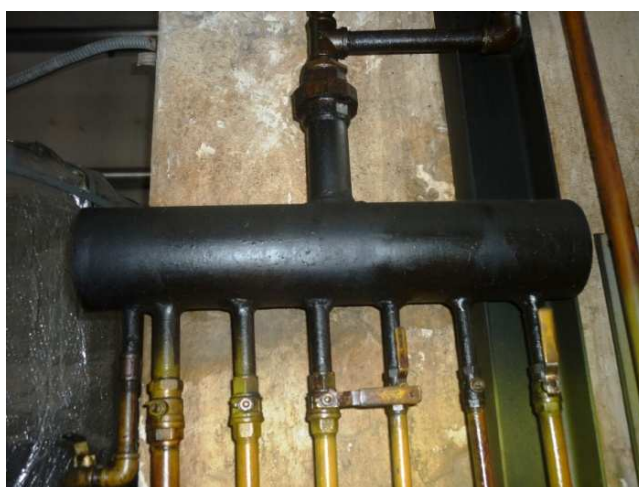
Figura 2.30. Sistema de distribución de combustible
