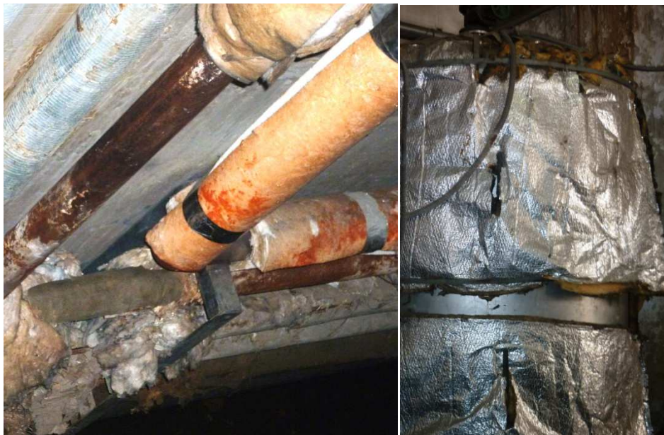
Figura 2.26. Condiciones de la lana de vidrio
