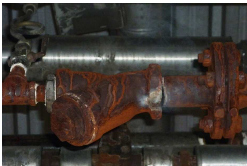
Figura 2.27. Trampa de vapor termodinámica
