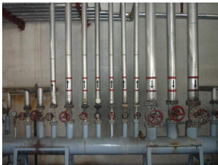
Figura 2.3. Distribuidor de vapor.
