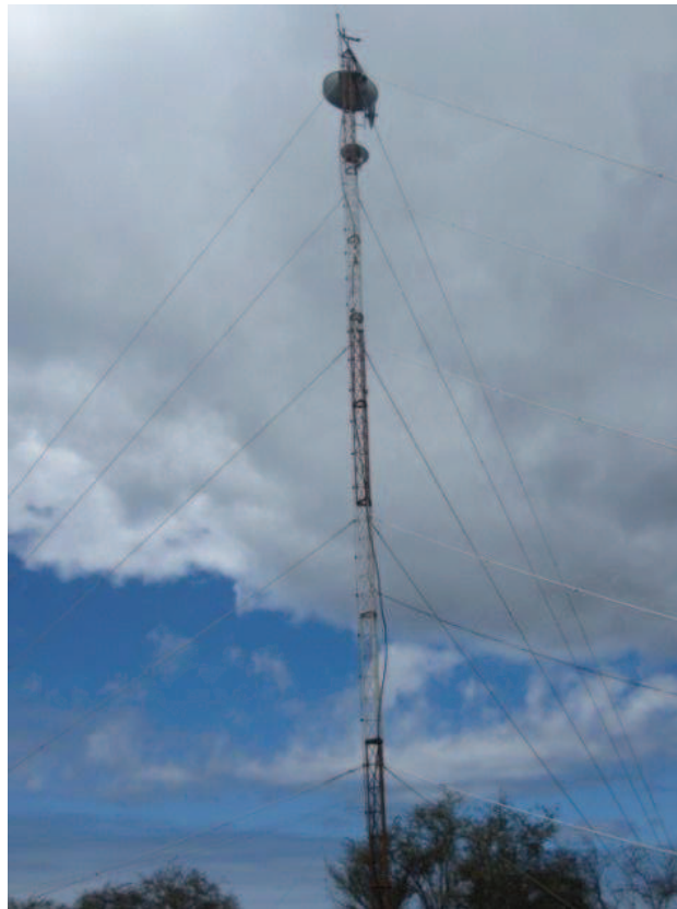
Figura 2.23 Torre en Puerto Velasco Ibarra (Floreana).
