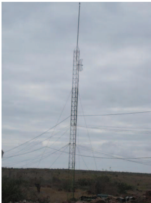
Figura 2.13 Fotografía de la Torre Aeropuerto perteneciente al CGREG.
