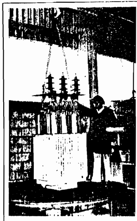
Proceso de entancado de un Transformador Trifásico.
