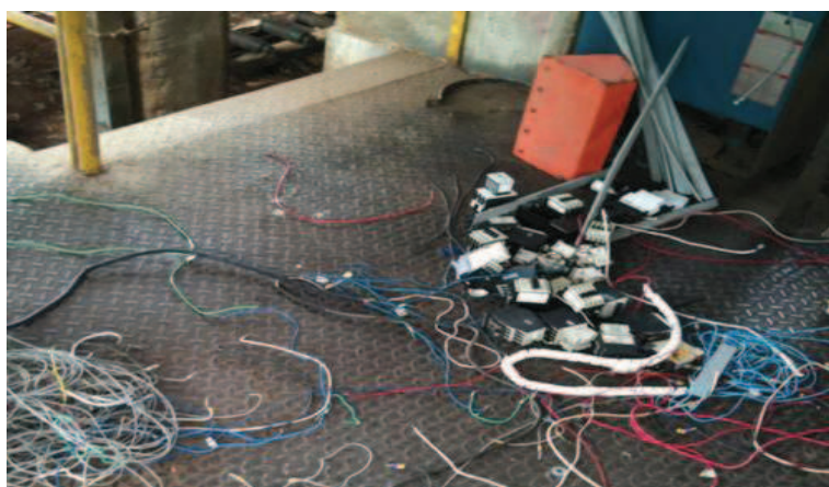
Figura 4-1 Desmontaje del Antiguo sistema de Control
