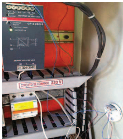
Figura 4-9 Montaje Transmisor de Corriente 4 – 20 [mA]
