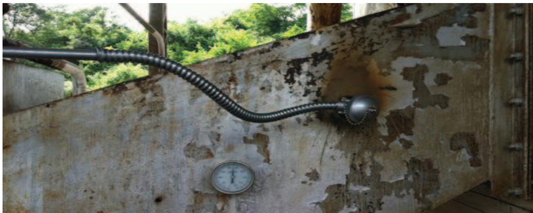
Figura 4-8 Instalación Final Sensor Pt100
