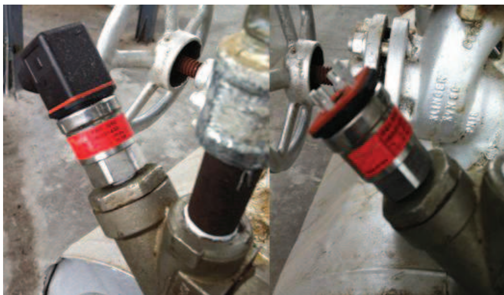
Figura 4-5 Instalación del Sensor de Presión MBS 3000
