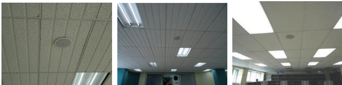
Figura 4.23 Montaje de los parlantes 1, 2 y 3, respectivamente
