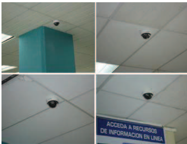
Figura 4.20 Montaje de las cámaras del Nivel I
