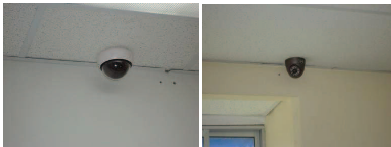
Figura 4.22 Montaje de las cámaras en el Nivel II
