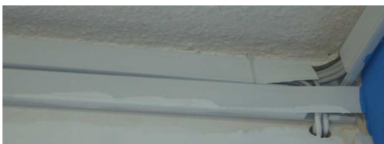
Figura N° 2.7 Cables instalados por orificios en la pared
