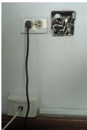
Figura N° 2.9 Punto de red a desnivel con tomacorriente
