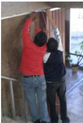
Figura N°4.4 Traslado de líneas telefónicas
