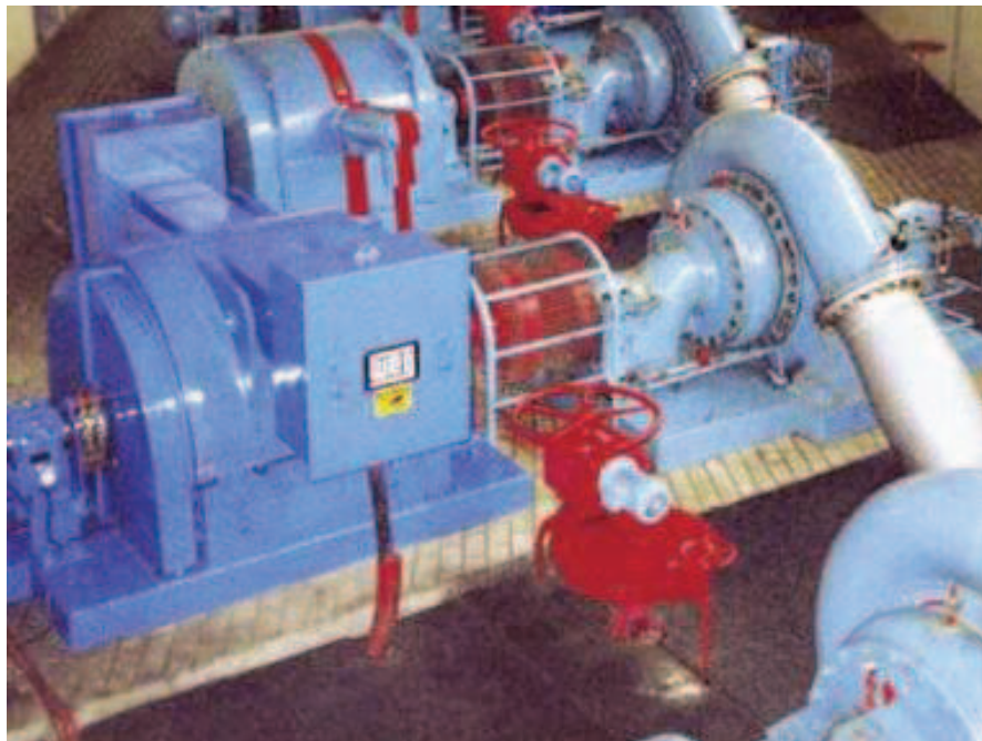
Figura 2.16. Aplicación: bomba. Motor síncrono SDA800, 2.500 HP, 6.600 V, 6 polos
