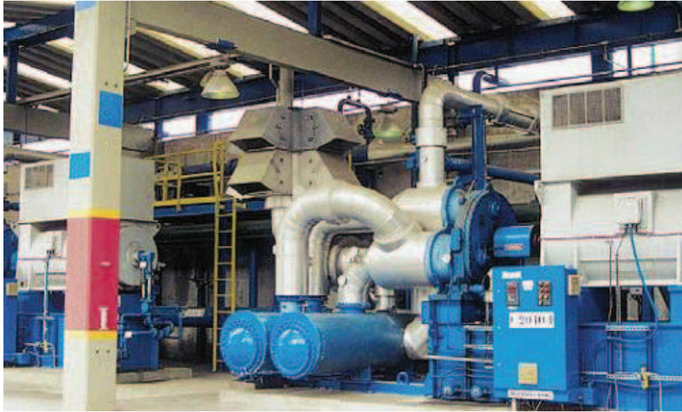
Figura 3.25. Aplicación: compresor para aire. 2 motores de inducción KGA560, 1.472 kW. 13.800 V, 2 polos.
