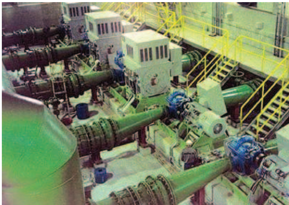
Figura 3.26. Aplicación: bombas centrífugas: 3 motores de inducción MGA560, 920 kW, 3.800 V, 8 polos; 3 motores de inducción HGF315, 258 kW, 3.800 V, 4 polos.
