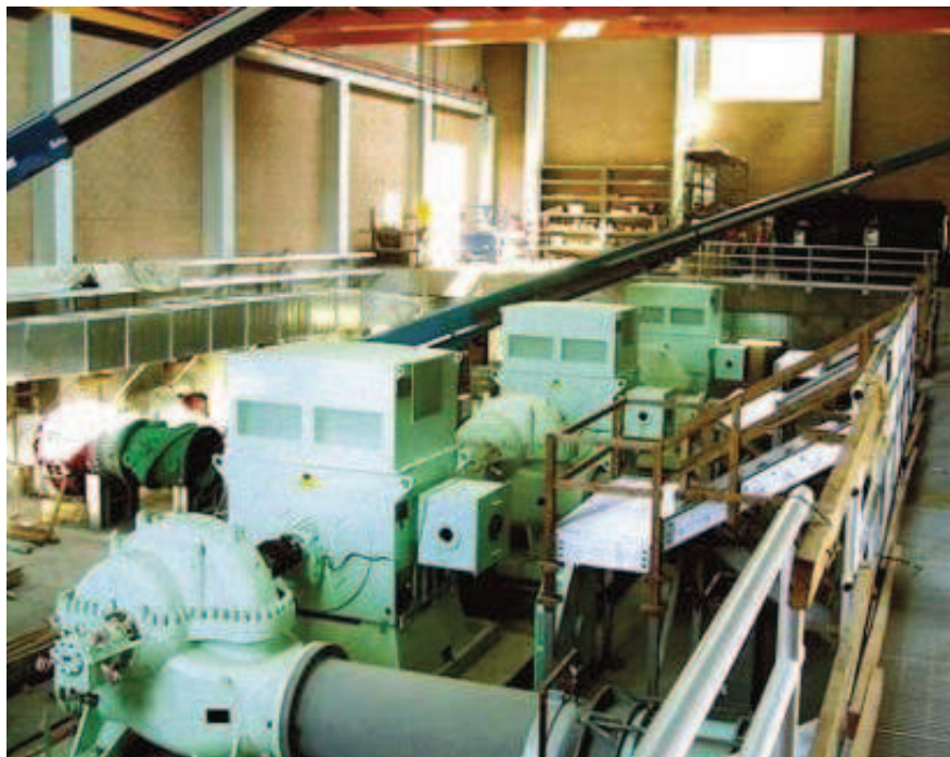
Figura 3.22. Aplicación: bombas. 3 motores de inducción MGA12806, 2.500 HP, 4.000 V, 8 polos.
