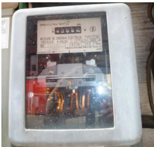
Figura 1.7 Anexo 1 Contador de Energía electromecánico trifásico 4 hilos
