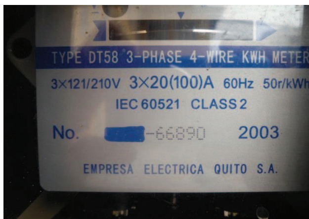
Figura 1.4 Anexo 1 Contador de Energía electromecánico trifásico 4 hilos
