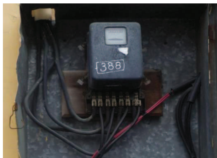
Figura 1.1 Anexo1 Contador de Energía electromecánico trifásico 4 hilos
