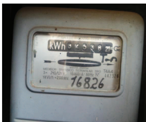
Figura 1.5 Anexo 1 Contador de Energía electromecánico trifásico 4 hilos
