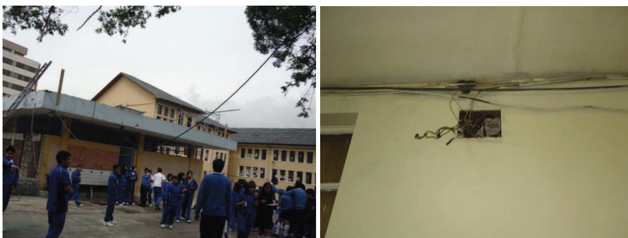
Figura 2.18 Peligro estado que se encuentran las Instalaciones Actuales
