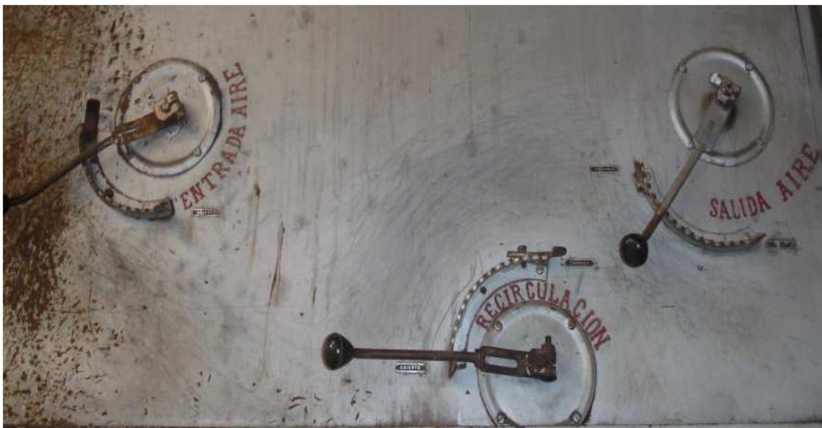
**Figura 2.8: Accionadores para entrada y salida de aire**
