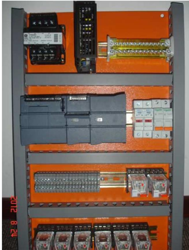
**Figura B: Instalación del tablero de control (2)**
