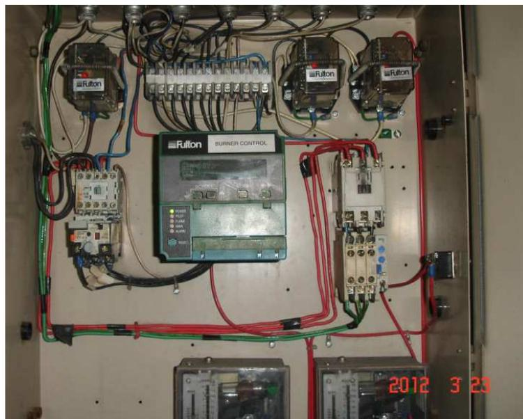
**Figura 2.7: Control automatizado del caldero**
