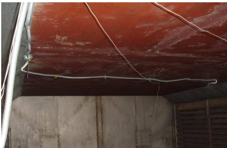
**Figura 2.37: Instalación de termopares en el Horno 2**
