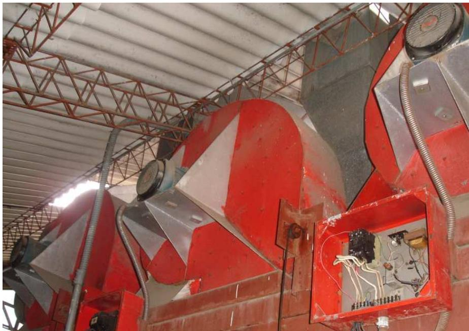
**Figura 2.10: Motores de recirculación Horno2**
