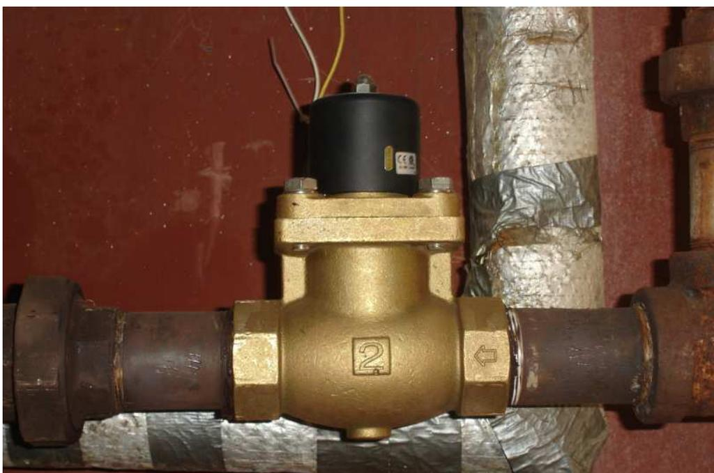
**Figura 2.35: Electroválvula instalada en el Horno 2**
