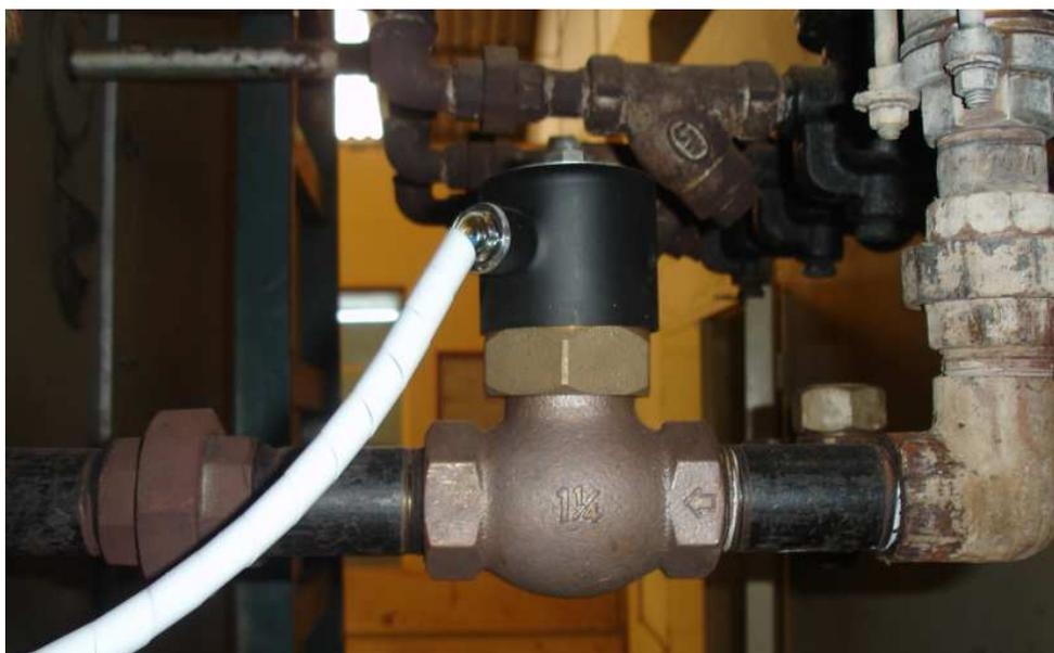
**Figura 2.34: Electroválvula instalada en el Horno 1**
