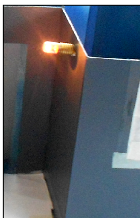
Figura 4. 9: Prueba encendido de Foco 1
