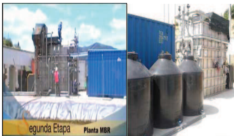
Figura 1.14. Vista panorámica de las instalaciones del tratamiento de lixiviado en el relleno sanitario “El Inga” - Planta MBR (Segunda Etapa) (Gasgreen, 2010)
