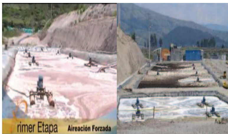
Figura 1.13. Vista panorámica de las instalaciones del tratamiento de lixiviado en el relleno sanitario “El Inga” - Aireación Forzada (Primera etapa) (Gasgreen, 2010)
