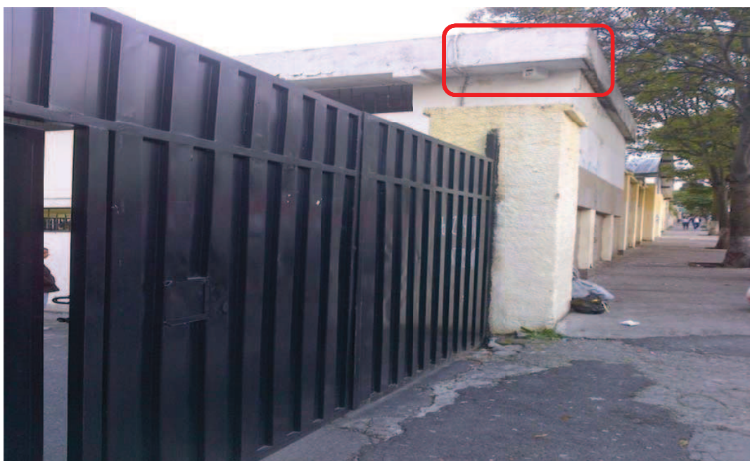
Figura 5.29 Instalación de la cámara IP BLC - 230 "CAM_C.P1.30"
