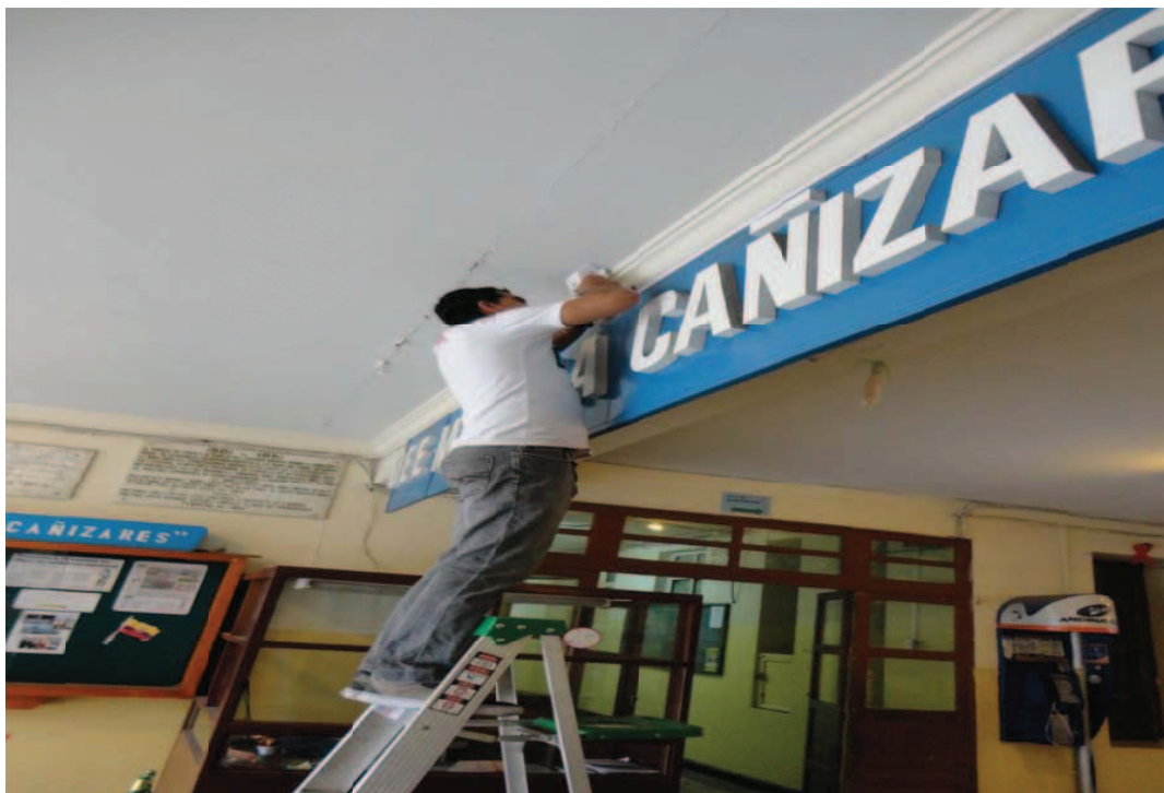
Figura 5.20 Instalación de la cámara IP BL - C1 “CAM_C.P1.3”
