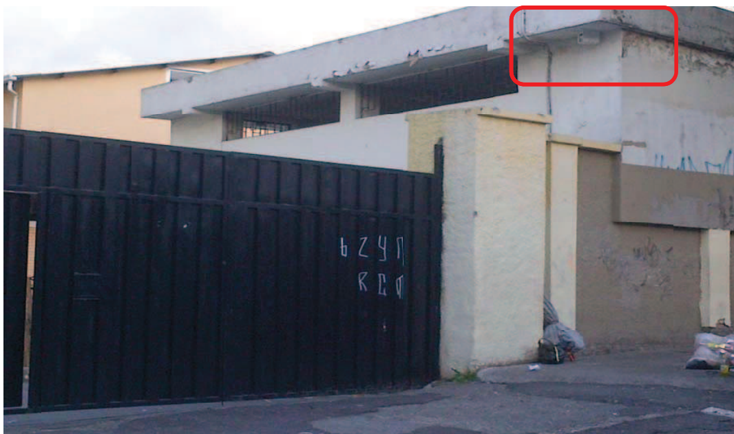
Figura 5.29 Instalación de la cámara IP BLC - 230 "CAM_C.P1.30"
