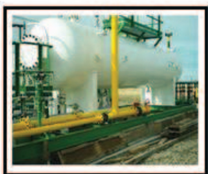
Figura 1.3 Separadores trifásico horizontal y vertical
