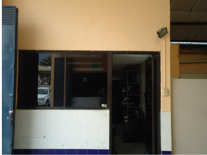
Foto 3-13 Vista exterior de la bodega
