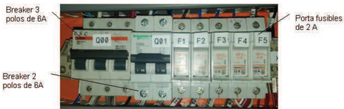
Figura. 9.6. Protecciones instaladas en el tablero.
