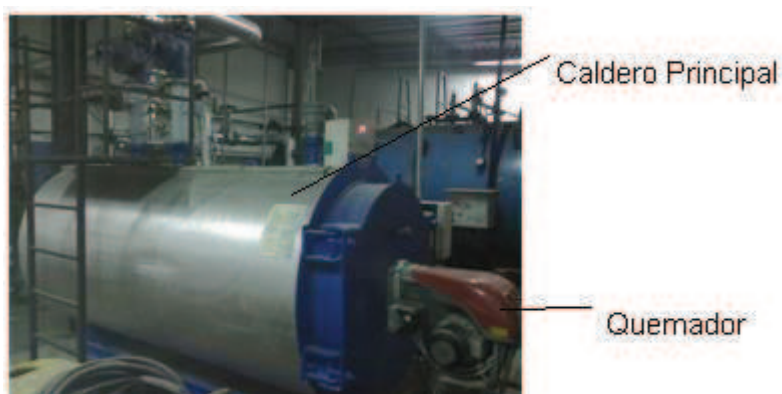
Figura.6.0. Caldero piro tubular principal.
