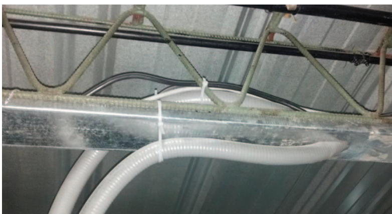
Figura.10.3. Canaletas instaladas en las inmediaciones del caldero.
