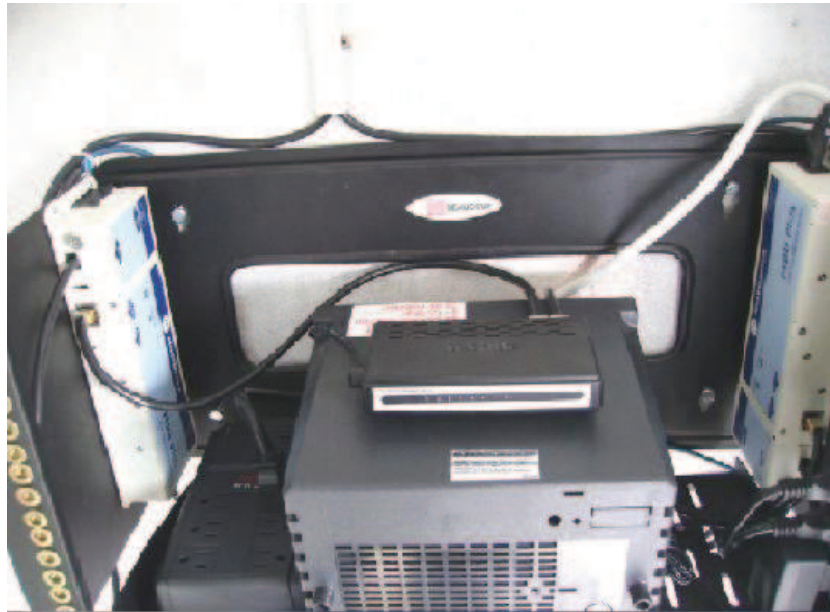
Figura 4.3.- Enlace instalado en la estación Clirsen.
