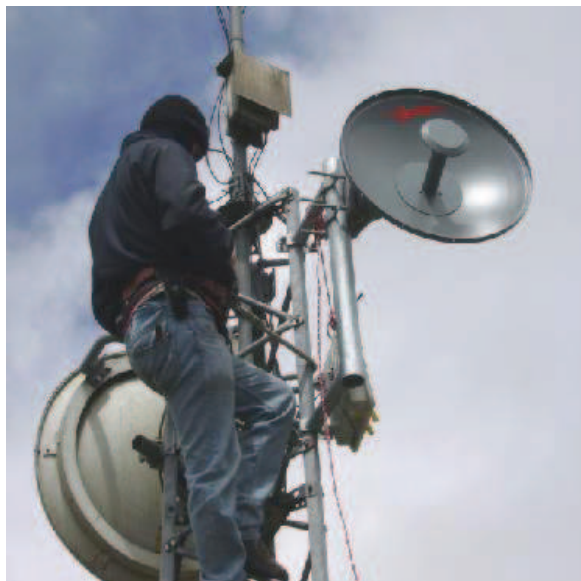
Figura 4.4- Antenas de los enlaces, una hacia el Atacazo y la otra dirigida a Putzalahua.
