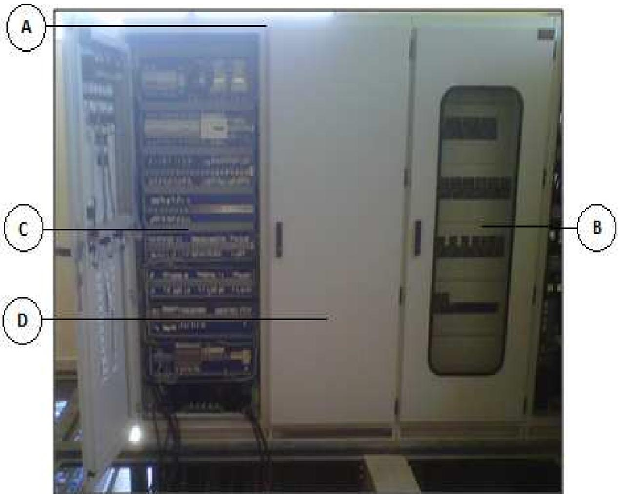
FIGURA: 1.17 TABLERO DE TRASFERENCIA AUTOMÁTICA Y DE DISTRIBUCIÓN PRINCIPAL.
