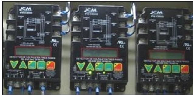
FIGURA: 2.15 SUPERVISORES DE DE VOLTAJE DEL TABLERO DE TRASFERENCIA.
