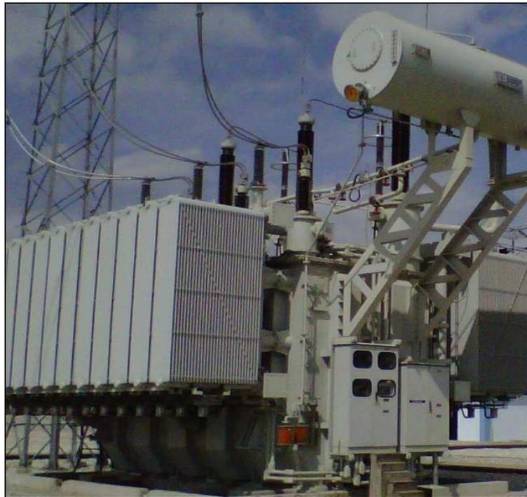
FIGURA: 1.13 AUTO TRASFOMADOR DE POTENCIA DE LA SUBESTACIÓN LAS ESCLUSAS
