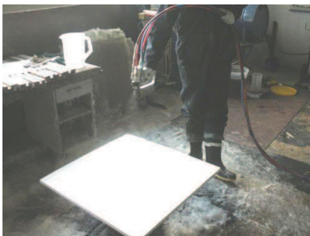
Figura 2.34. Aplicación de gelcoat.
