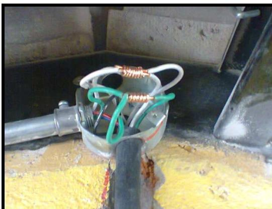
Fig. 3.1 Empalme en una caja octagonal
