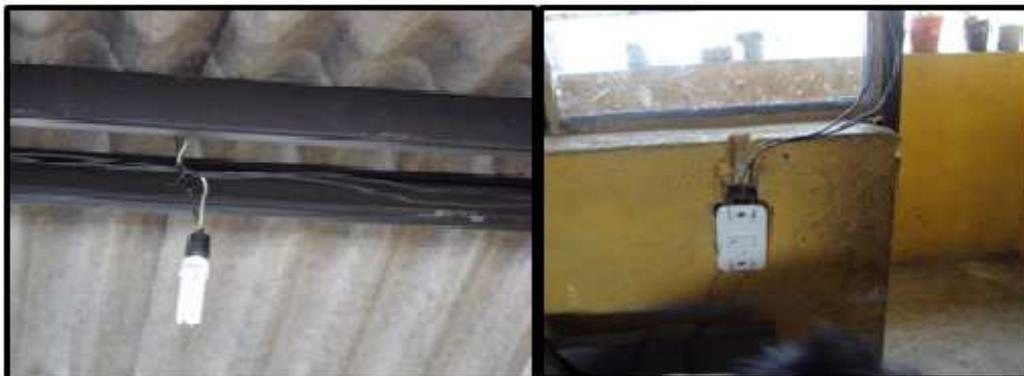
**Fig. 2.12. Estado actual de los circuitos de iluminación**
