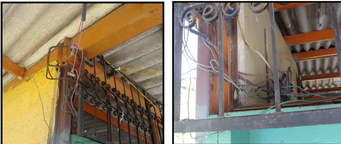
**Fig.3.4 Ingreso de Alimentadores a Subtablero de Distribución en aulas del Tramo Inferior**
