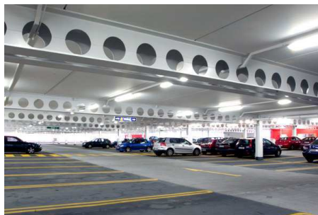
Figura 2. 17 Garaje de parqueo
