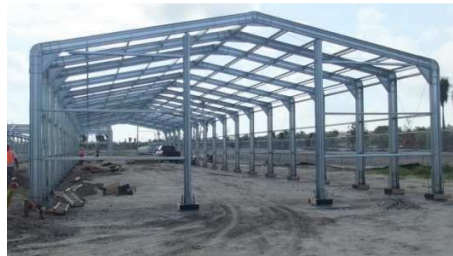
Figura 1.1 Estructura de acero 1
