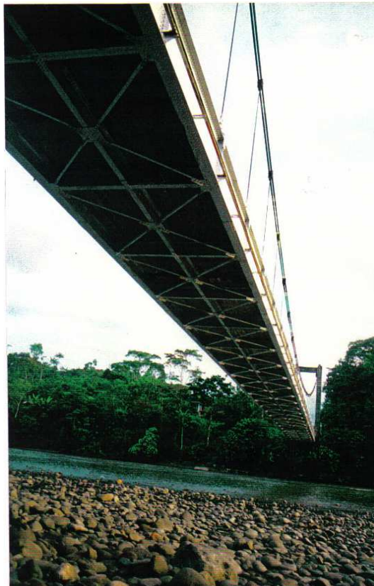
FOTOGRAFÍA Nº 6 ESTRUCTURA INFERIOR DEL PUENTE DE TRAMO TENA- PUERTO NAPO SOBRE EL RÍO NAPO
