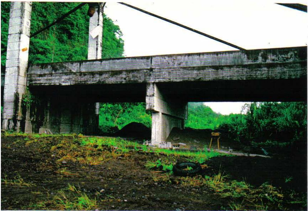
FOTOGRAFÍA Nº 4 CIMIENTOS DEL PUENTE DE TRAMO RÍO PASTAZA-MACAS SOBRE EL RÍO COPUENO
