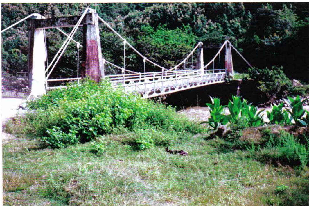
FOTOGRAFÍA Nº 14 LATERAL DEL PUENTE DE TRAMO RÍO PINDO-PORTOVELO SOBRE EL RÍO PINDO
