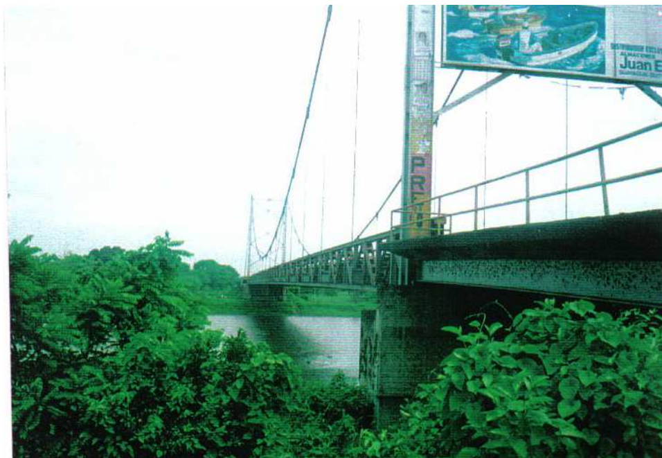
FOTOGRAFÍA Nº 11 LATERAL DEL PUENTE DE TRAMO EMPALME-NOBOL SOBRE EL RÍO DAULE
