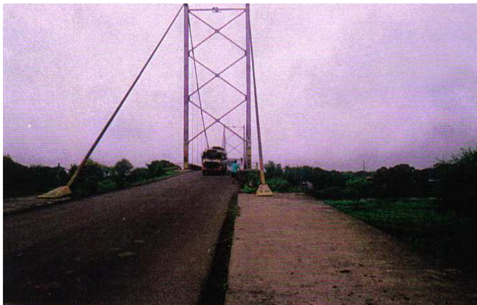
FOTOGRAFÍA Nº 12 FRONTAL ANVERSO DEL PUENTE DE TRAMO EMPALME-NOBOL SOBRE EL RÍO DAULE
