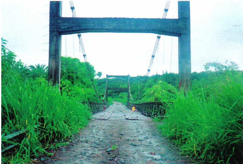
FOTOGRAFÍA Nº 9 FRONTAL ANVERSO DEL PUENTE DE TRAMO PATRICIA P.- STA. MARÍA SOBRE EL RÍO BABA
