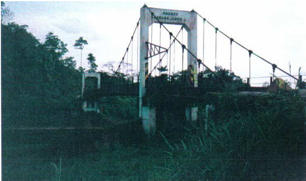
FOTOGRAFÍA Nº 16 LATERAL IZQUIERDA DEL PUENTE DE TRAMO RÍO km 19 EL ESFUERZO SOBRE EL RÍO BABA
