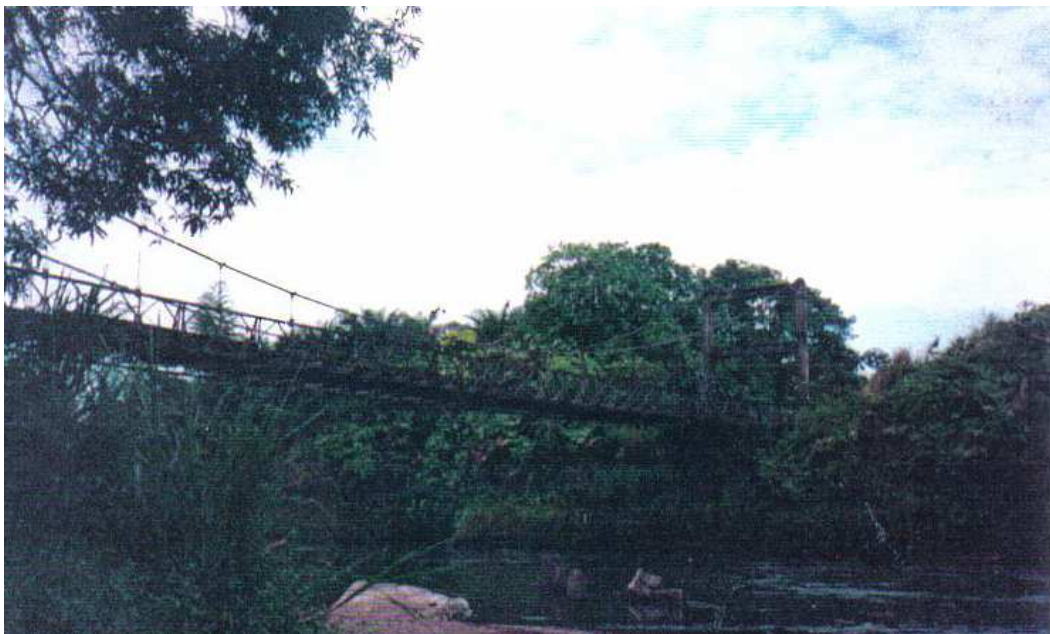
FOTOGRAFÍA Nº 20 LATERAL INFERIOR DERECHA DEL PUENTE DE TRAMO PATRICIA- COOP. 14 DE ABRIL SOBRE EL RÍO BABA
