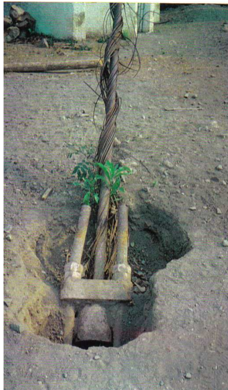
FOTOGRAFÍA Nº 18 CABLE PRINCIPAL DEL PUENTE DE TRAMO PUYANGO- PUYANGO VI SOBRE EL RÍO PUYANGO VIEJO
