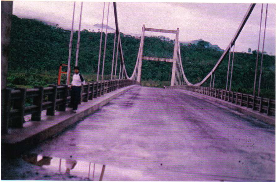
FOTOGRAFÍA Nº 1 FRONTAL DEL PUENTE DE TRAMO RÍO PASTAZA-MACAS SOBRE EL RÍO PASTAZA
