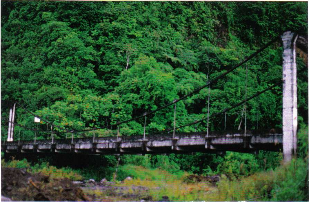
FOTOGRAFÍA Nº 3 LATERAL DEL PUENTE DE TRAMO RÍO PASTAZA-MACAS SOBRE EL RÍO COPUENO
