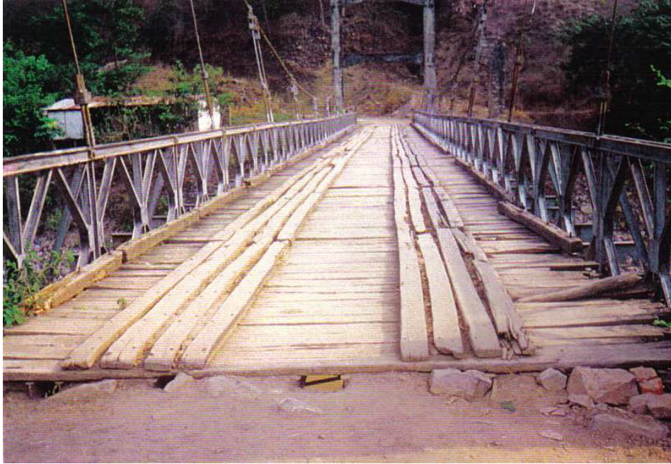
FOTOGRAFÍA Nº 17 FRONTAL DEL PUENTE DE TRAMO PUYANGO-PUYANGO VI SOBRE EL RÍO PUYANGO VIEJO
