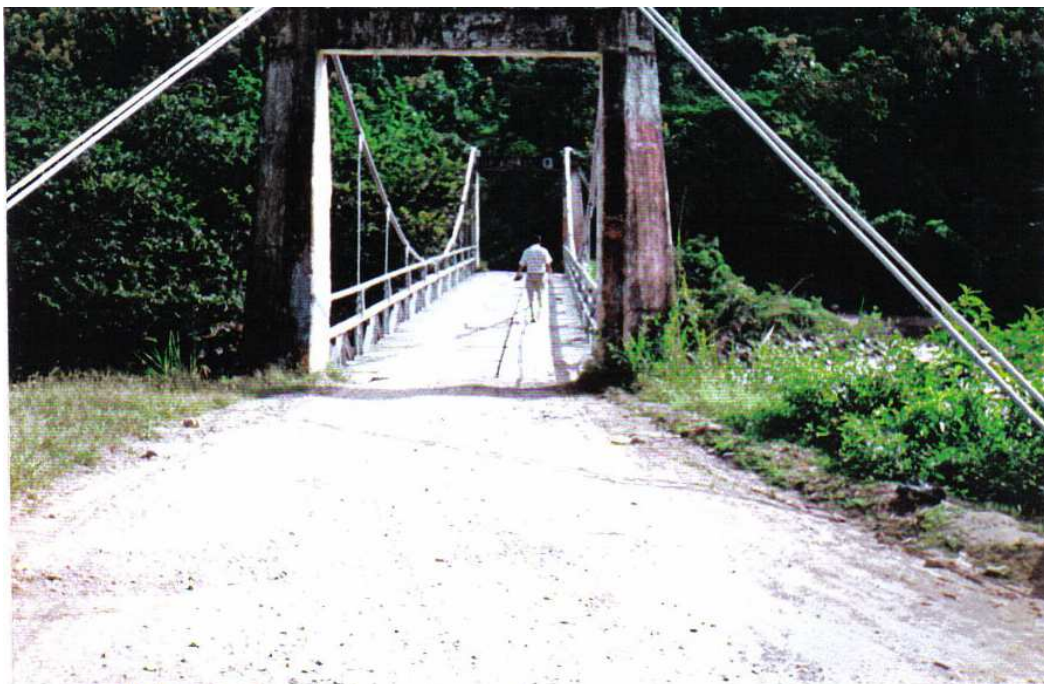
FOTOGRAFÍA Nº 13 FRONTAL DEL PUENTE DE TRAMO RÍO PINDO-PORTOVELO SOBRE EL RÍO PINDO
