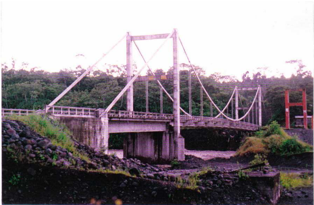
FOTOGRAFÍA Nº 2 LATERAL DEL PUENTE DE TRAMO RÍO PASTAZA-MACAS SOBRE EL RÍO PASTAZA
