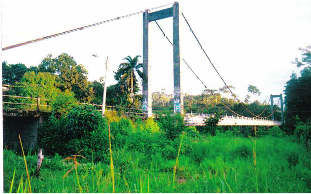
FOTOGRAFÍA Nº 5 LATERAL DEL PUENTE DE TRAMO TENA-PUERTO NAPO SOBRE EL RÍO NAPO
