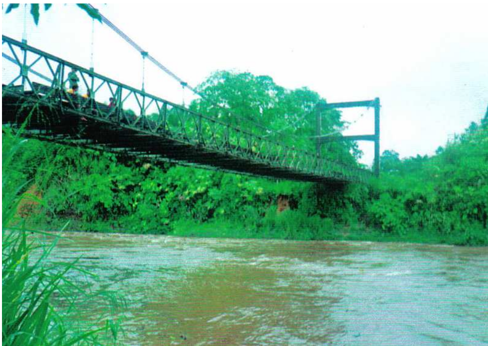
FOTOGRAFÍA Nº 10 LATERAL DEL PUENTE DE TRAMO PATRICIA P.-STA. MARÍA SOBRE EL RÍO BABA
