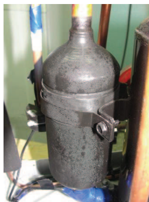
Figura 5.3 Separador del equipo de pruebas 121
