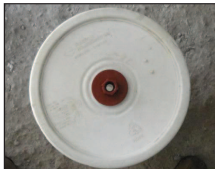
Figura 5. 21 Adaptadores para tanque de almacenamiento a la entrada y salida del agua caliente.
