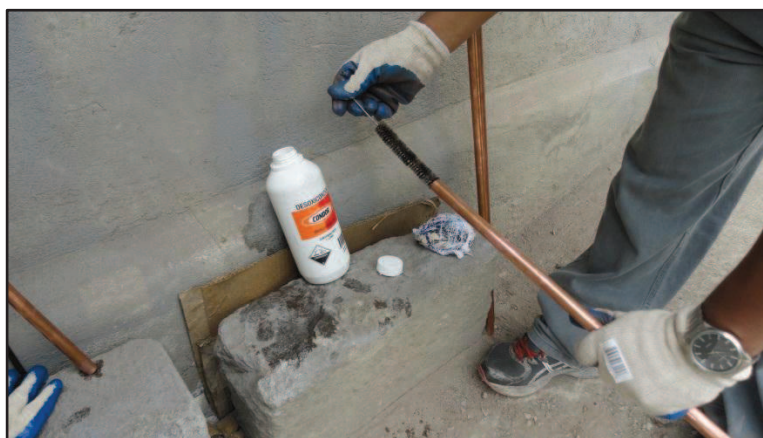
Figura 5. 1 Limpieza del interior de los tubos de cobre
