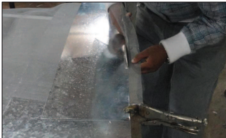
Figura 5. 3 Corte de malla de aluminio para adaptación de la mecha capilar
