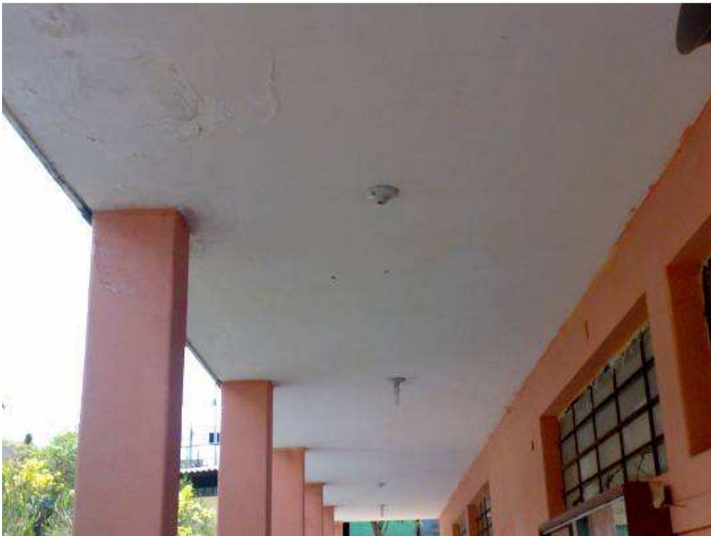
Foto 10. Colocación de cableado y plafones para el corredor de aulas 4, 5, 6.
