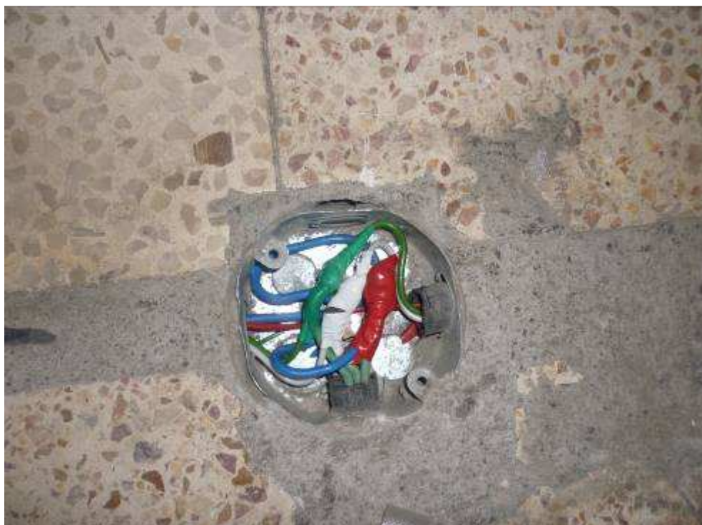
Foto 20. Empalmes nuevos circuito de fuerza, aula de computación.
