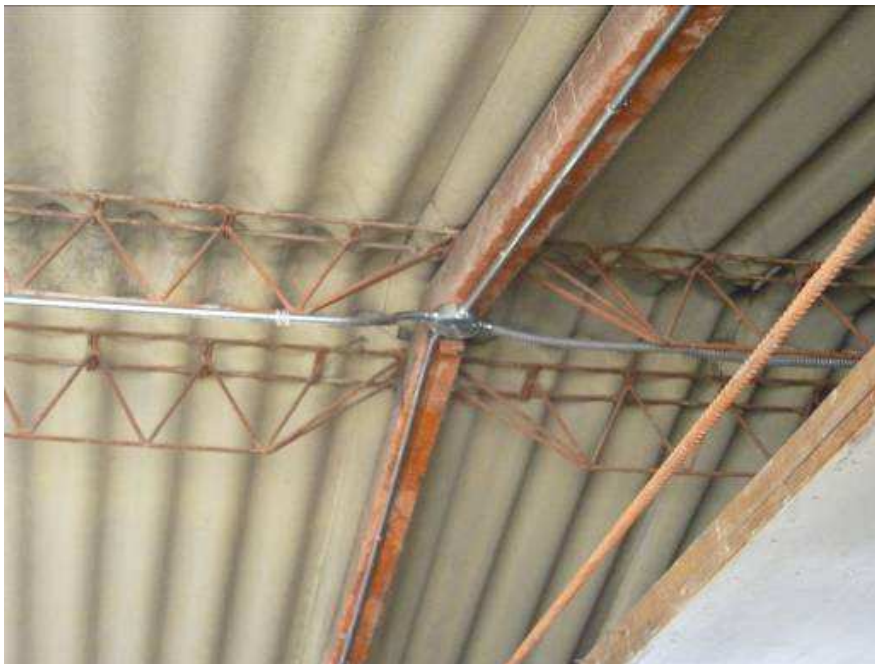
Foto 6. Instalaciones nuevas del circuito de iluminación aula de computación.
