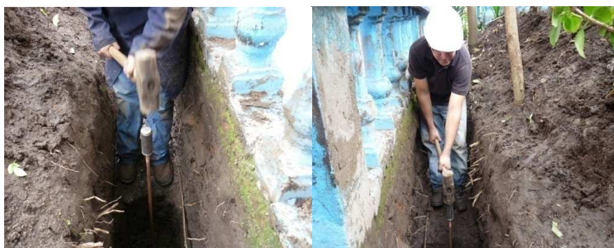
Foto 25. Colocación de varillas.
