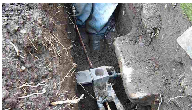
Foto 26. Colocación del molde.
