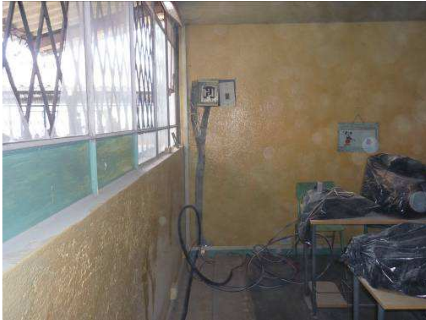
Foto 17. Colocación tableros nuevos y nueva manguera circuitos de fuerza aula de computación.
