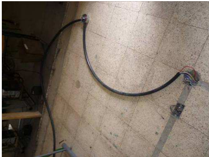
Foto 16. Colocación manguera para el nuevo circuito de fuerza.
