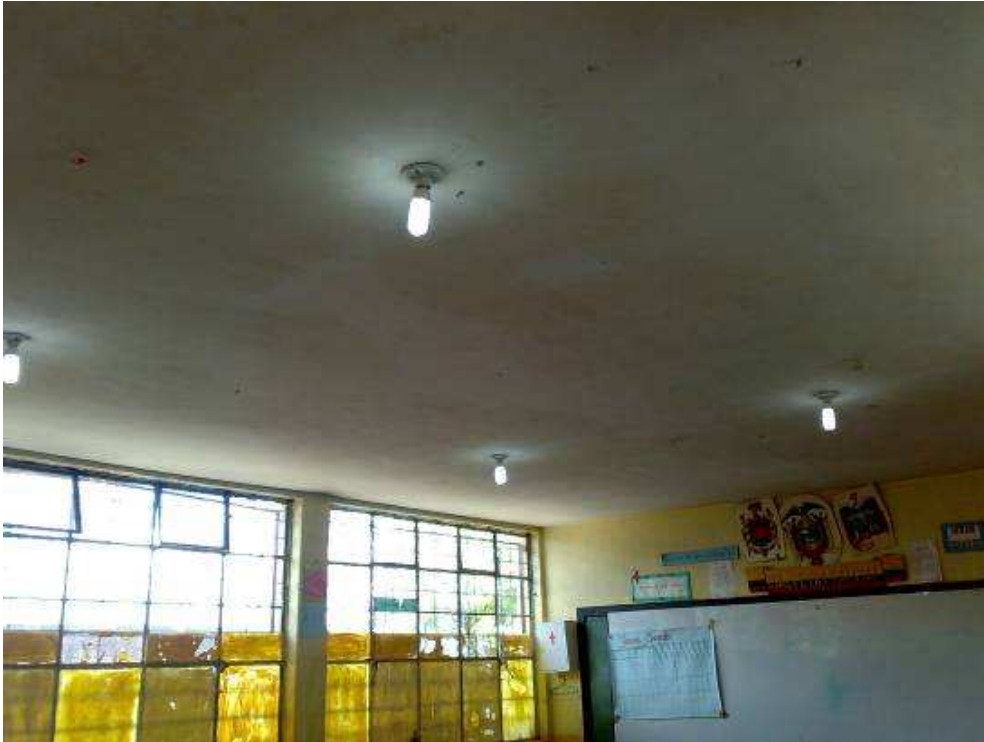
Foto 9. Cambio de cableado y plafones iluminación bloque aulas 4, 5, 6.
