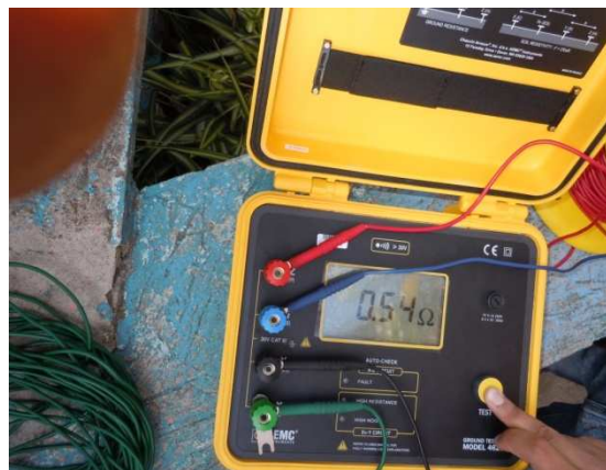
Foto 22. Medición de la resistencia del suelo previo a la ejecución de la instalación de la malla.
