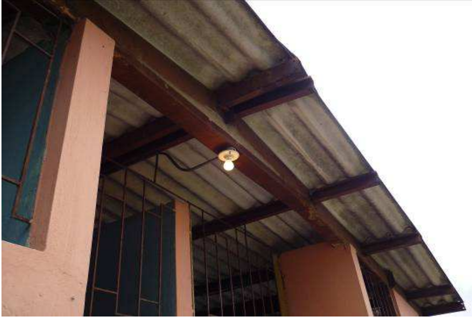
Foto 15. Colocación de un foco externo en el baño 3.
