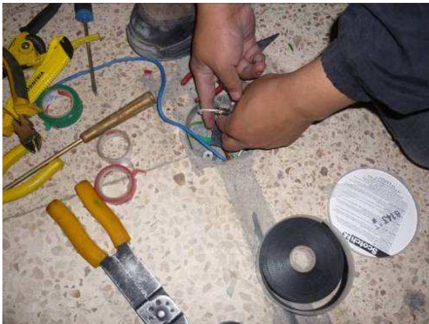
Foto 18. Instalación nuevo cableado y empalmes circuitos de fuerza.
