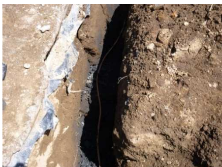
Foto 24. Excavación del terreno.
