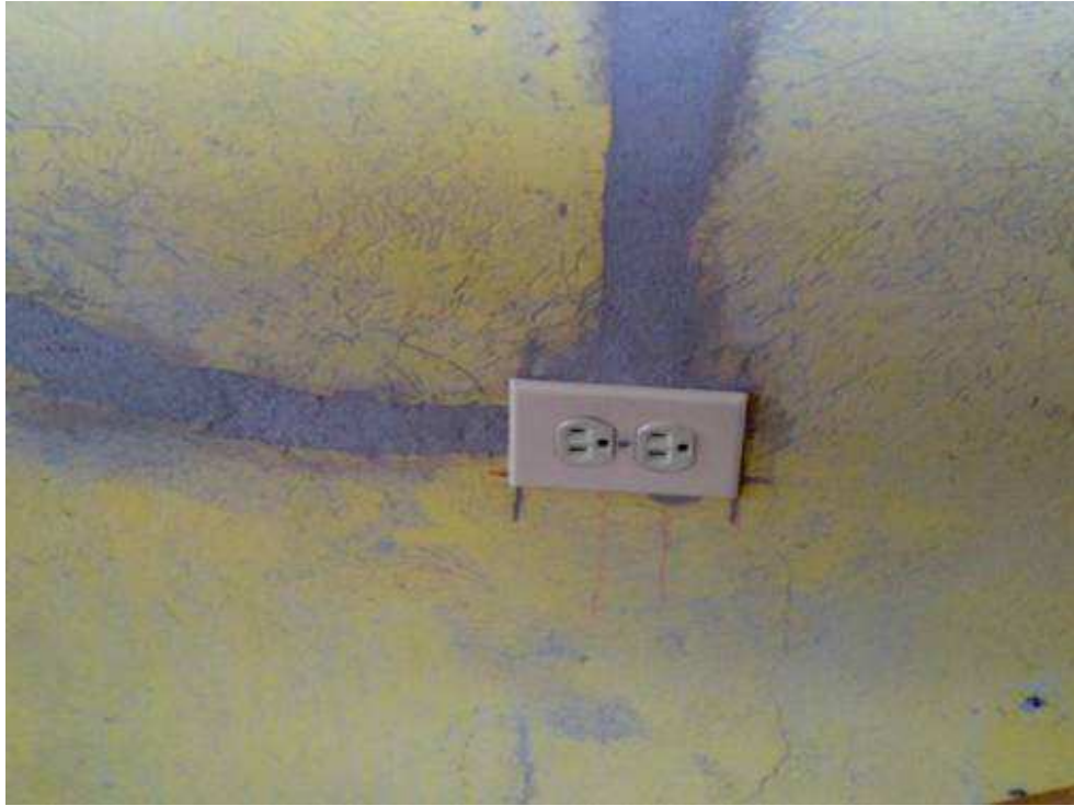
Foto 21. Instalación de manguera, cableado y tomas en aulas.
