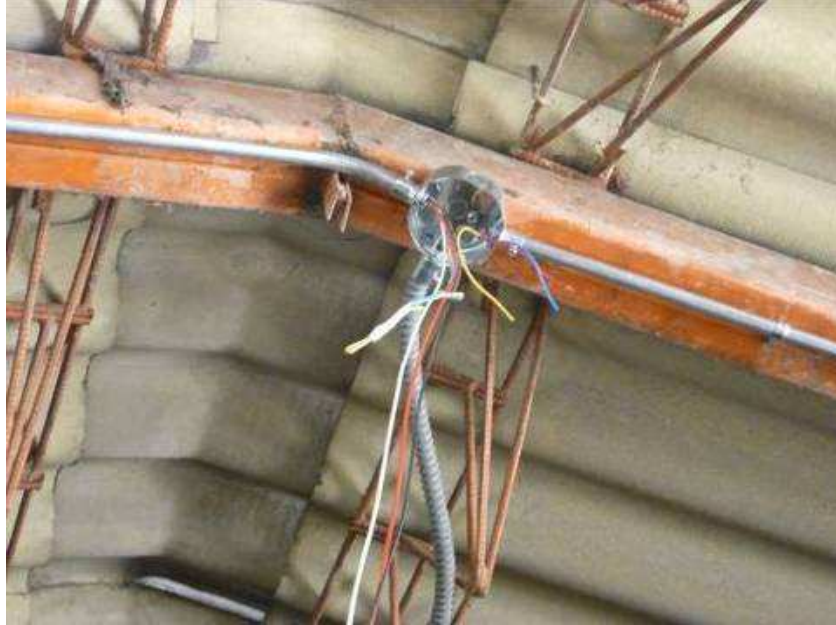
Foto 5. Colocación nueva tubería conduit, cajetines y cableado en el circuito de iluminación del aula de computación.
