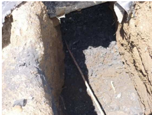
Foto 28. Colocación de carbón vegetal
