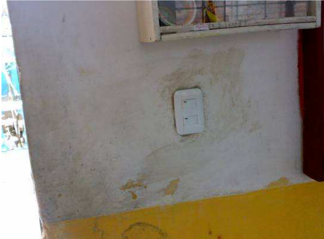
Foto 11. Interruptores nuevos, aulas 4, 5, 6.
