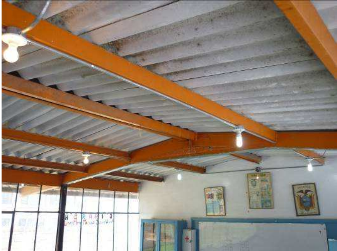
Foto12. Instalaciones nuevas, aula 3.
