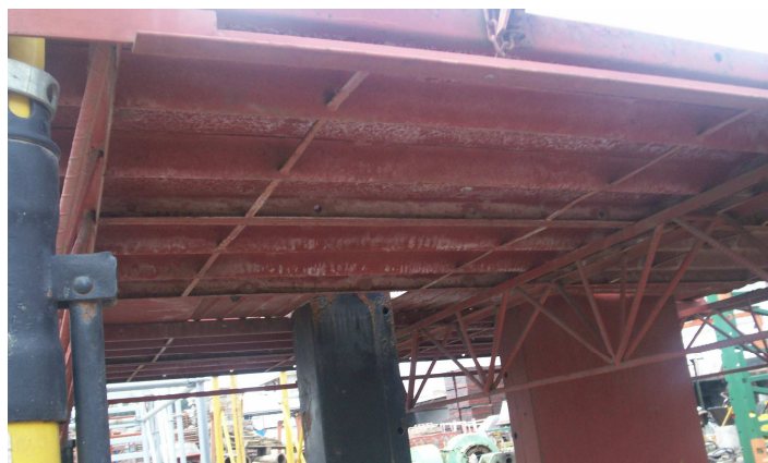
Figura 1.22 Sistema del encofrado una vez armado
