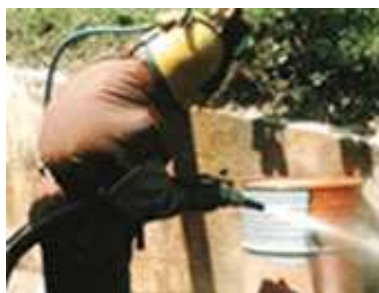
Figura 1.25 Limpieza por medio de chorro de arena
