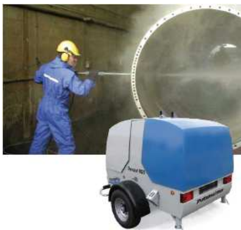
Figura 1.32 Limpieza de superficies por medio de chorro de vapor
