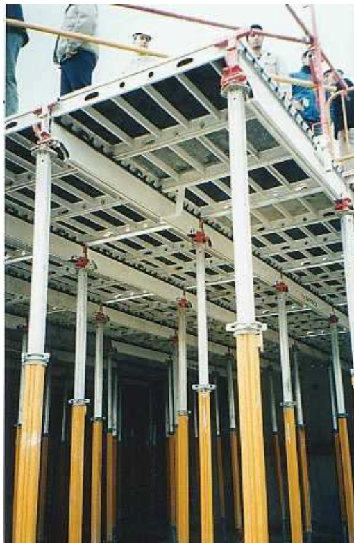
Figura 1.1 Esquema de un sistema de encofrado.
