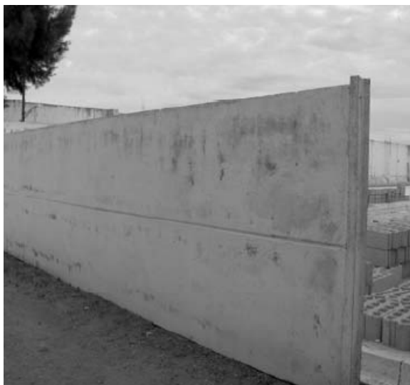
Fig. 1.4 Estructura con Hormigón
