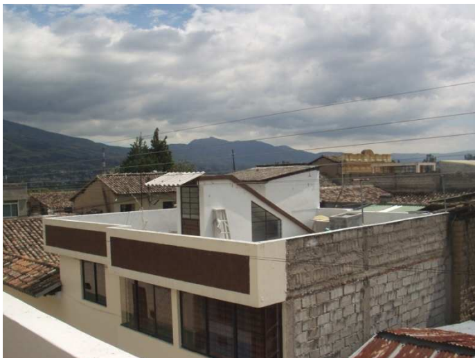
Figura 5. 3. Lugar donde se instalo el Aerogenerador. 74
