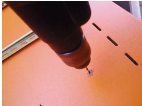
**Figura 2.26.** Perforación para sujeciones tablero
