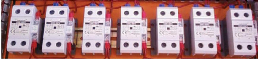
**Figura 2.17.** Contactores de electroválvulas
