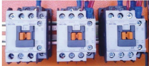
**Figura 2.16.** Contactores del tablero de control.
