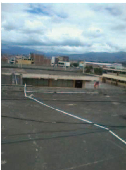
Figura 2.7: Tendido del cableado por encima del techo del Bloque A
