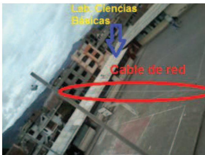
Figura 2.10: Tendido de cable de red de manera aérea
