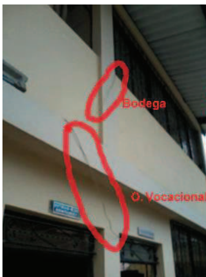
Figura 2.9: Ingreso del cable de red a las oficinas O. Vocacional (1er piso) y Bodega (2do piso)
