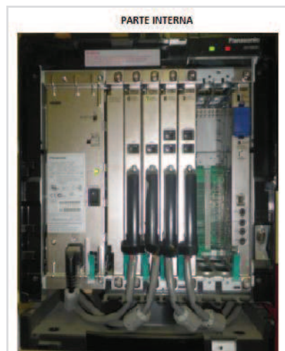
Figura 2. 9 Central Telefónica PANASONIC
