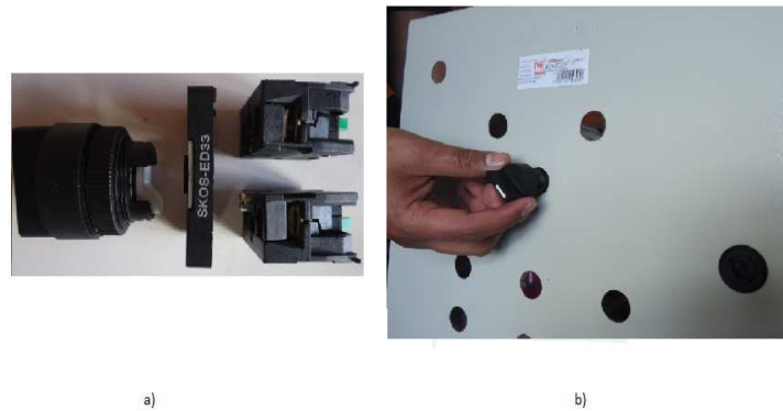
Figura 4.4 a) Despiece del selector de tres posiciones, b) colocación del selector de tres posiciones
