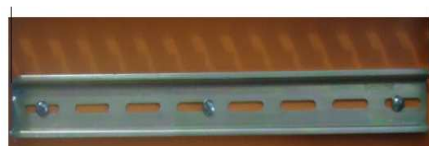
Figura 4.7 Riel din colocado en el doble fondo del gabinete metálico
