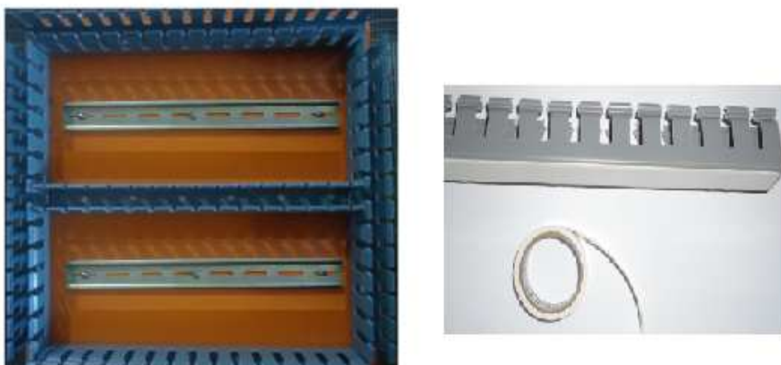
Figura 4.8 Distribución de las canaletas ranuradas y colocación cinta doble faz
