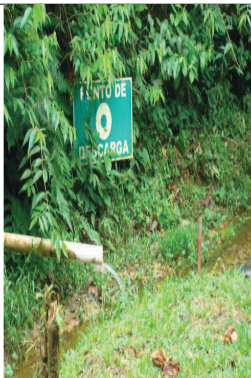
Foto No. 4.- Descarga de aguas negras y grises del Campamento DONATERRA – Bloque 16
