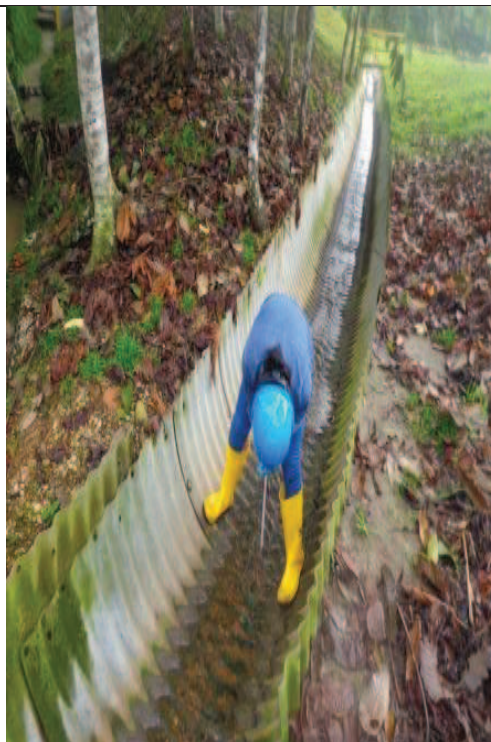
Foto No. 6.- Medida de Caudal de escorrentía – Bloque 16
