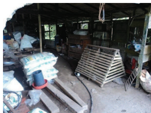
Figura IV.12. Evidencia de la evaluación inicial del punto de control CB.5.5.2
