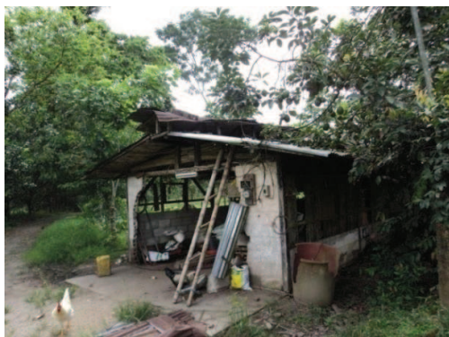
Figura IV.13. Evidencia de la evaluación inicial de los puntos de control CB.5.5.3 CB.8.7.2
