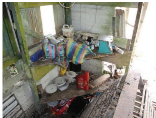
Figura IV.16. Evidencia de la evaluación inicial del punto de control CB.8.7.9
