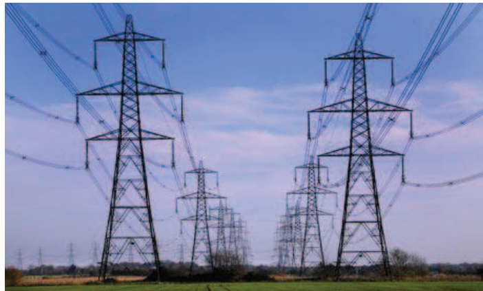
Figura2.1 Líneas de transmisión doble circuito multifase.
