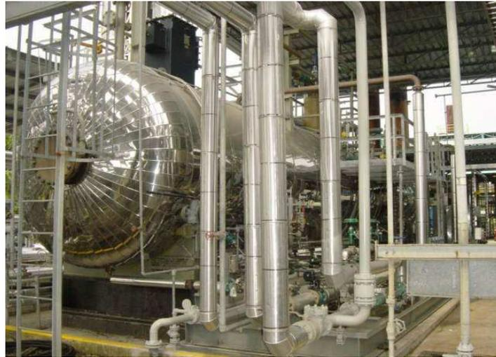
Para la deshidratación se utilizan tubos de fuego (firtubes) que van por el interior del “Heater-Treater”, estos tubos son calentados por flama directa, utilizando quemadores con combustible de crudo procesado, previamente calentado y pulverizado, para que la combustión sea casi completa, es decir con liberación de CO<sub>2</sub> y vapor de agua. También se tiene quemadores con combustible gas, el cual se obtiene como producto del proceso mismo.
