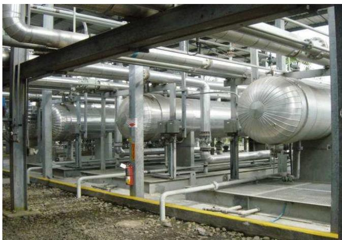
A continuación, el crudo entra al separador de agua libre (FWKO de las siglas en inglés Free Water Knock Out) en el cual choca con placas metálicas produciéndose la separación de agua, crudo y gas debido a su diferencia de densidades. Este equipo se muestra en la figura 1.5.
