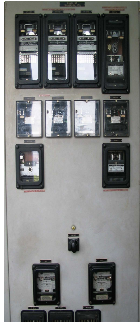
Fig.11 Vista posterior tablero dúplex
